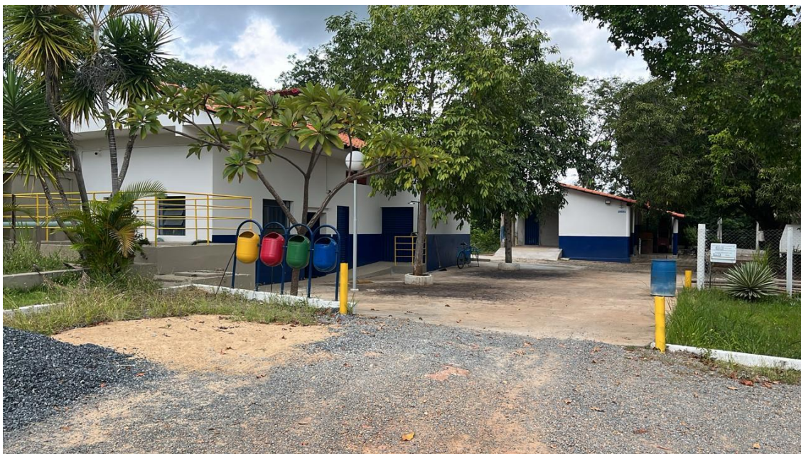
Figura 25: Estação Elevatória de água tratada.
