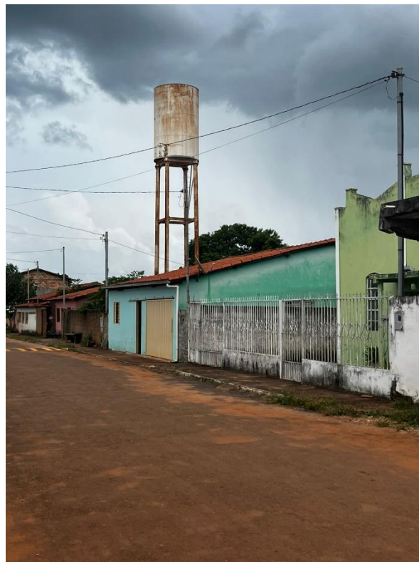
Figura 27: Reservatório de água do Distrito de Barracão.
