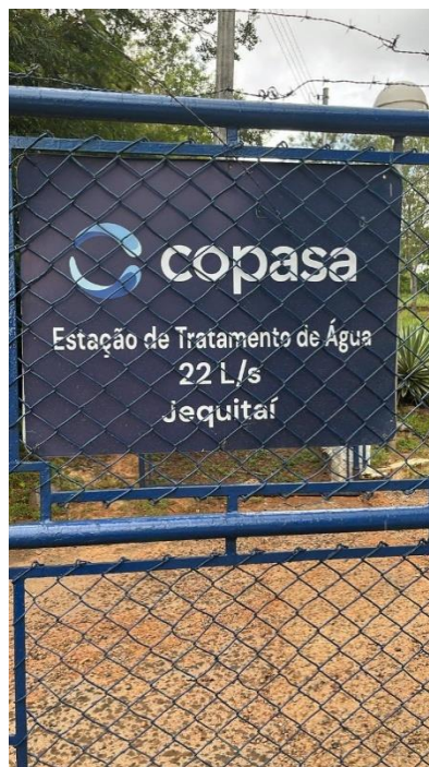
Figura 23: Estação de Tratamento de Água. Fonte: CODANORTE, 2026
